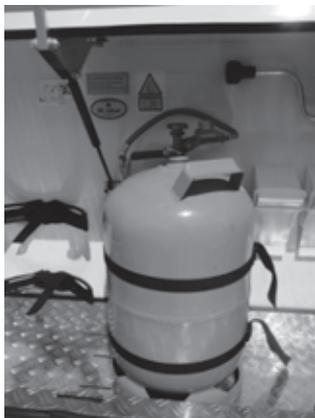
Fig. 96 : Bouteille de gaz avec détendeur
