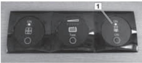
Fig. 79 : Boutons Marche/Arrêt du chauffage au sol
