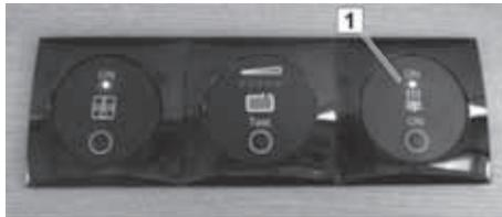
Fig. 119 : Boutons Marche/Arrêt du chauffage au sol
