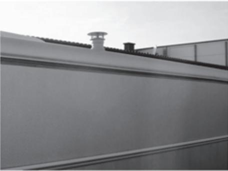
Fig. 78: Conduit d'évacuation des gaz brûlés du chauffage à gaz
