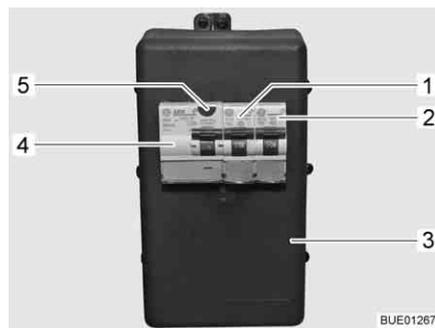
Fig. 94 Caja de fusibles de 230 V con interruptor de protección de línea e interruptor FI
