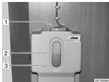
Bild 197 Expansionsbehållare varmvatten-värmesystem
