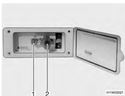
Bild 97 Extern gasanslutning, gasavstängningsventilen stängd
