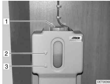
Bild 199 Ausgleichsbehälter Warmwasser-Heizung
