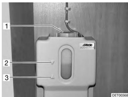
Billede 199 Udligningsbeholder varmtvandsvarmeovn
