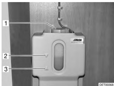
Bild 199 Expansionsbehållare varmvatten-värmesystem
