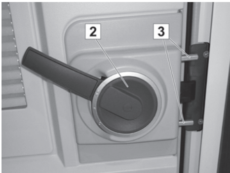
Abb. 15: Tür geschlossen und gesichert
