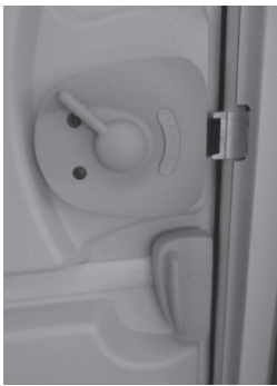
Abb. 21: Hebel oben, Türschloss verriegelt
