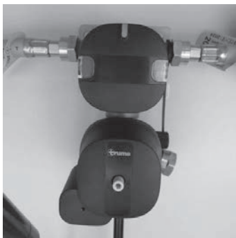
Abb. 103: Gasversorgung DuoControl CS
