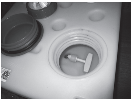
Abb. 89: Ablasstopfen im Frischwassertank
