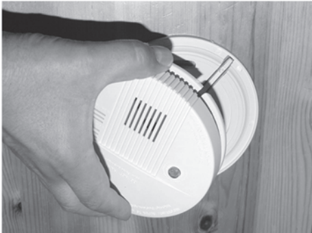
Abb. 108: Gehäuse abnehmen
