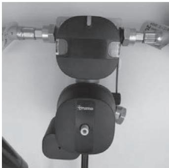
Fig. 77: Suministro de gas (con Eis-Ex e indicación a distancia)
