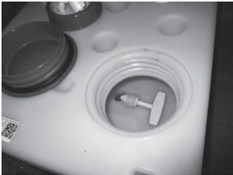
Fig. 97: Tapón de descarga en el tanque de agua fresca
