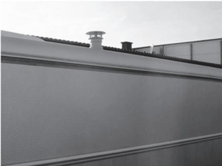
Fig. 83: Chimenea de gases de escape de la calefacción a gas
