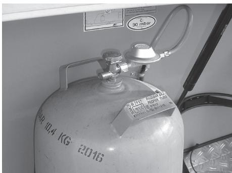
Fig. 101: Botella de gas con válvula reductora de presión
