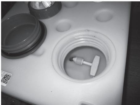
Fig. 89: Tapón de descarga en el tanque de agua fresca
