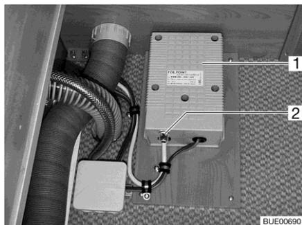
Fig. 224 Trasformatore per riscaldamento elettrico del pavimento
