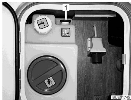
Fig. 254 Depósito de agua (unidad de servicio)
