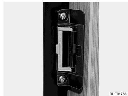
Fig. 246 Dispositivo de cierre en posición de ventilación
