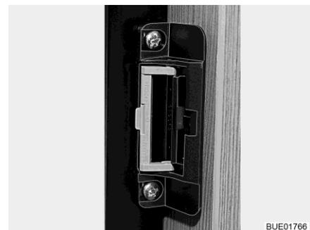
Bild 85 Verschlusseinrichtung in Lüftungsstellung
