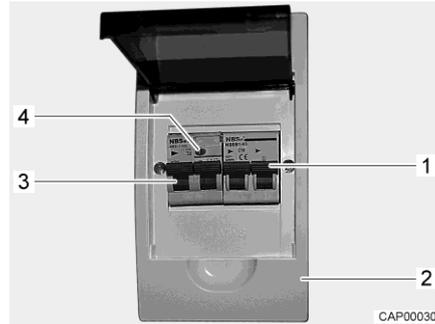
Bild 46 Leitungsschutzschalter und FI-Schalter (230-V-Sicherungskasten)
