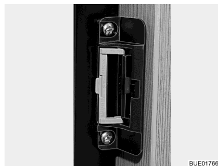
Fig. 270 Dispositif de fermeture en position de ventilation
