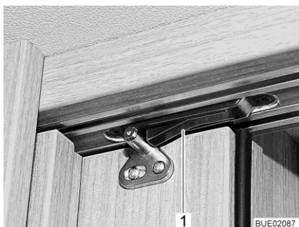
Fig. 16 Cran d'arrêt à ressort
