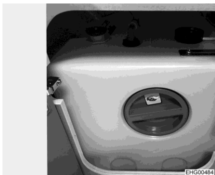
Fig. 57 Depósito de agua
