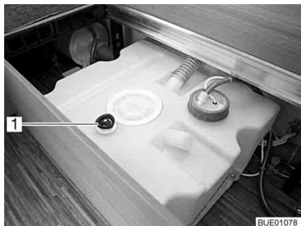
Fig. 165 Depósito de agua
