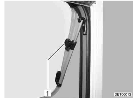
Fig. 46 Fenêtre projetante avec bras pivotants, ouverte
