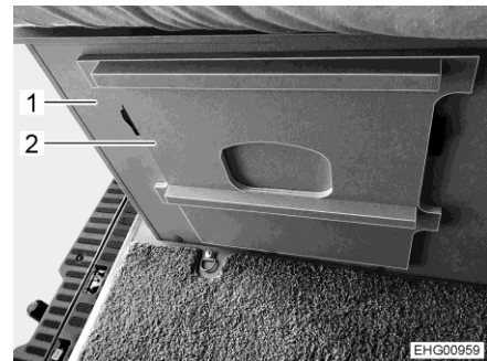
Kuva 7 Väliseinä tavaratilassa (Delfin C)
