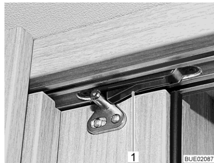
Bild 10 Spärr med fjäder
