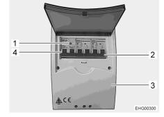
Fig. 206 230 V fuse box (variant)
