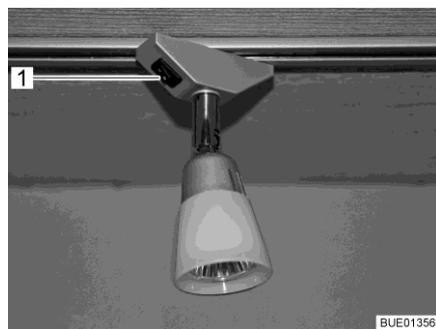
Bild 75 Spotleuchte, Lichtschalter direkt an der Leuchte
