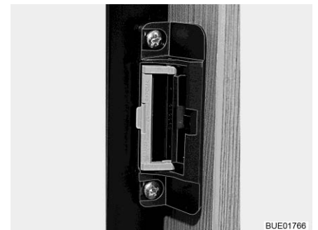
Bild 136 Verschlusseinrichtung in Lüftungsstellung
