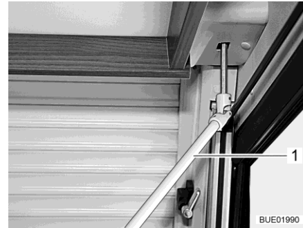
Bild 107 Handkurbel für Notbetrieb
