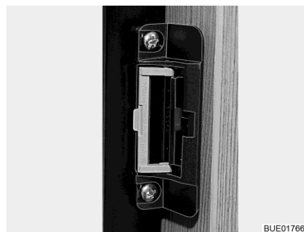
Fig. 259 Dispositif de fermeture en position de ventilation
