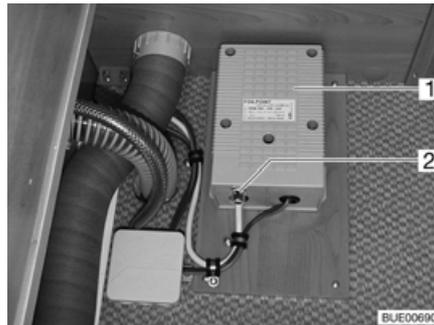
Fig. 166 Transformador para calentamiento eléctrico del piso
