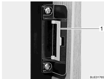
Billede 241 Låseanordning i normalstilling
