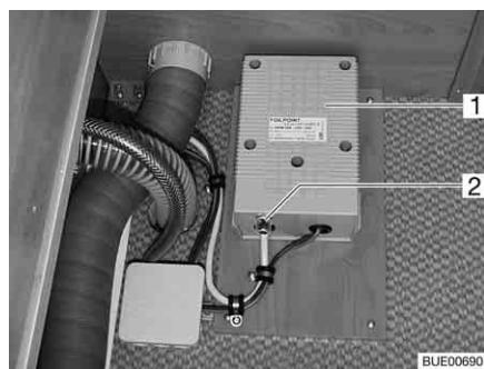
Kuva 144 Sähköisen lattialämmityksen muuntaja
