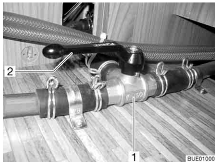
Fig. 193 Vanne à 3 voies
