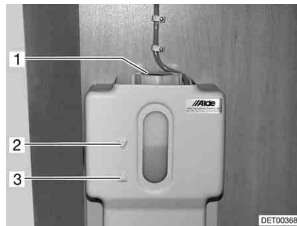
Afb. 260 Buffertank met afscherming
