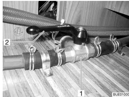
Fig. 193 Válvula de 3 vías
