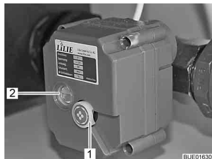
Bild 212 Elmanövrerad avtappningskran
