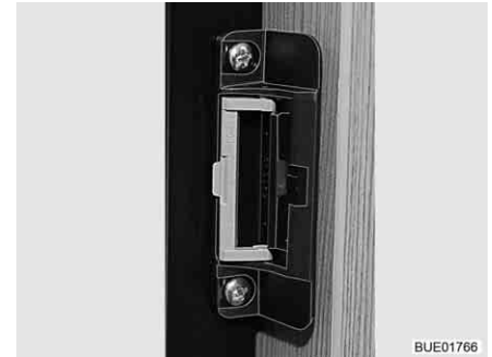
Bild 205 Verschlusseinrichtung in Lüftungsstellung
