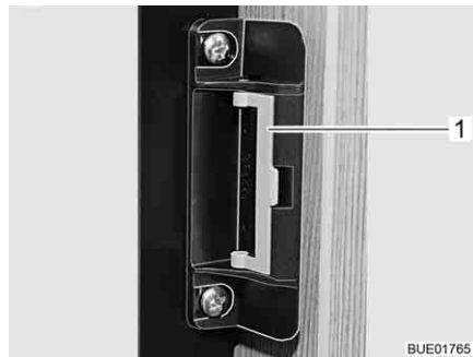
Fig. 204 Dispositivo de cierre en posición normal
