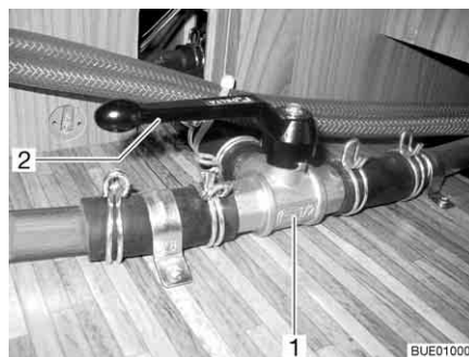
Fig. 172 Válvula de 3 vías
