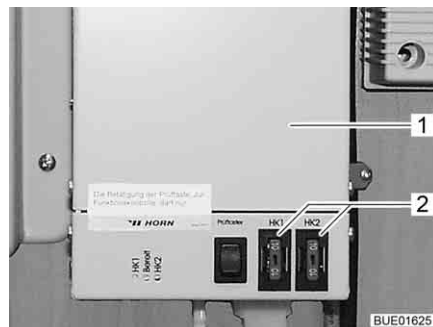
Bild 171 Regulator för avloppsledningarnas värmesystem
