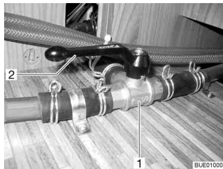
Kuva 197 Kolmitieventtiili
