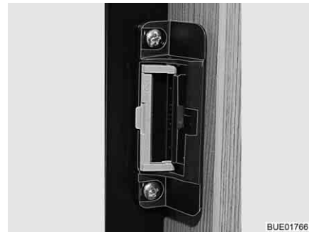
Billede 226 Låseanordning i udluftningsstilling
