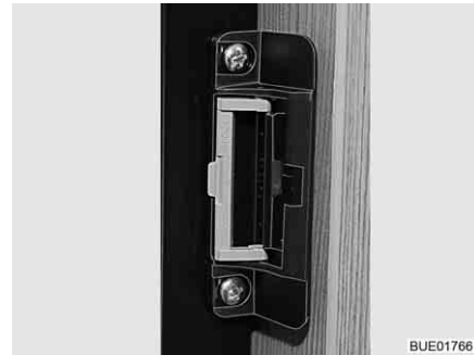
Bild 226 Låsanordning i ventilationsläge
