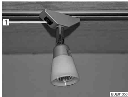
Bild 44 Spotleuchte, Lichtschalter direkt an der Leuchte
