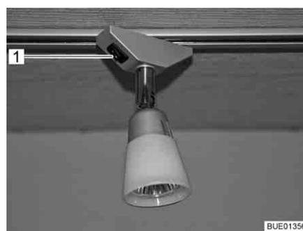
Fig. 62 Projetor de halogéneo, interruptor da luz encontra-se diretamente na luz
