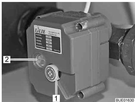
Fig. 204 Válvula de descarga de acionamento elétrico
