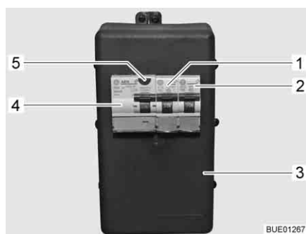
Afb. 172 230-V-zekeringenkast met beveiligingsautomaat en FI-schakelaar
