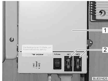
Fig. 116 Régulateur du chauffage des conduites des eaux usées
