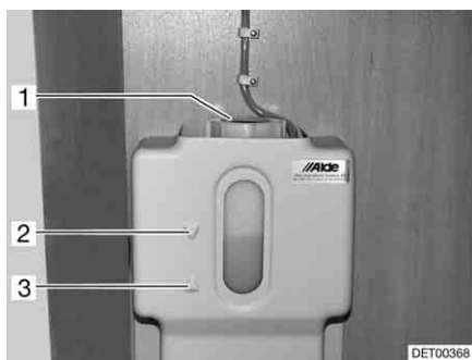
Bild 235 Ausgleichsbehälter Warmwasser-Heizung
