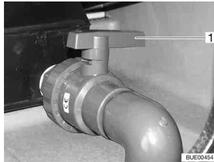
Fig. 198 Llave de desagüe (en el doble fondo)
