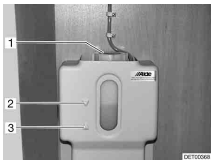
Fig. 235 Recipiente de compensación para la calefacción de agua caliente
