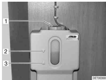
Bild 281 Ausgleichsbehälter Warmwasser-Heizung
