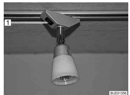
Bild 54 Halogenspotleuchte, Lichtschalter direkt an der Leuchte
