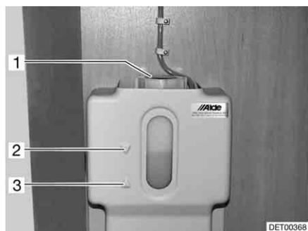
Fig. 250 Vaso d'espansione del riscaldamento ad acqua calda
