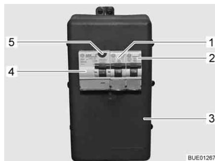
Fig. 136 Scatola dei fusibili a 230 V con interruttore di sicurezza e interruttore automatico FI
