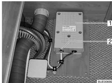
Bild 168 Trafo für elektrische Fußbodenerwärmung
