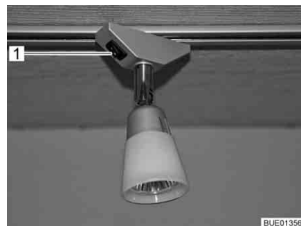
Billede 53 Halogenspotlampe, lyskontakt direkte ved lampen
