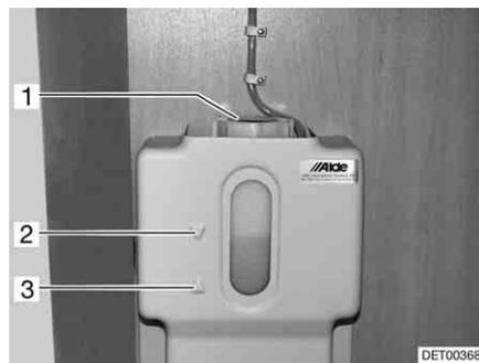
Bild 247 Ausgleichsbehälter Warmwasser-Heizung
