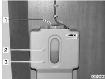
Kuva 196 Tasaussäiliö kuumavesilämmitin
